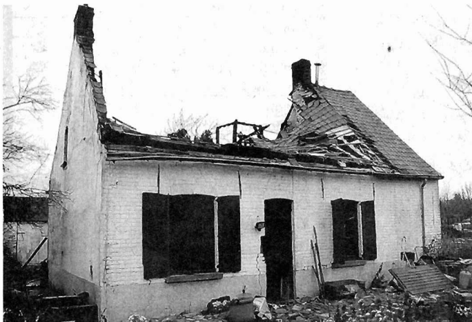
De woning aan Broekelken 28 brandde volledig uit. Foto JVK
