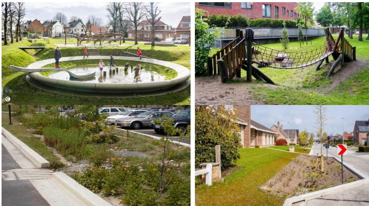
Figuur 34: Voorbeelden laagteberging en infiltratie in het openbaar domein: Edegemsesteenweg Kontich (links boven) en een speeltuin in Brugge (rechts boven), bron: blauwgroenvlaanderen.be. Voorbeelden van gat in boordsteen (links onder) en verlaagde verkeersdrempel (rechts onder), bron: Aquafin
